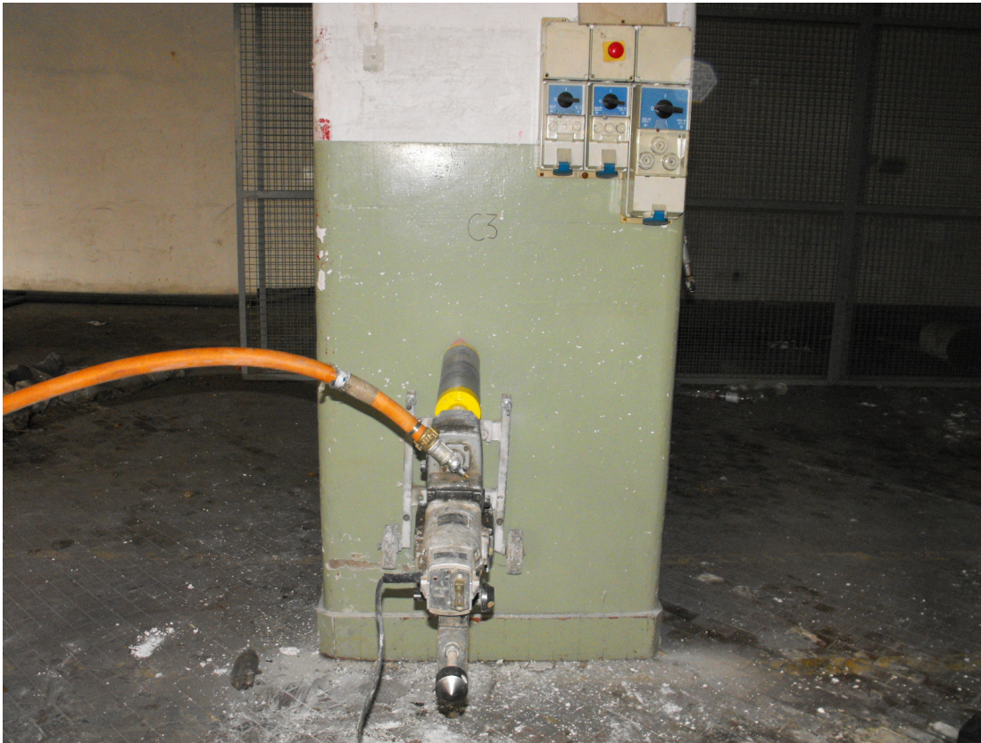
C3 – Pilastro 2° piano
