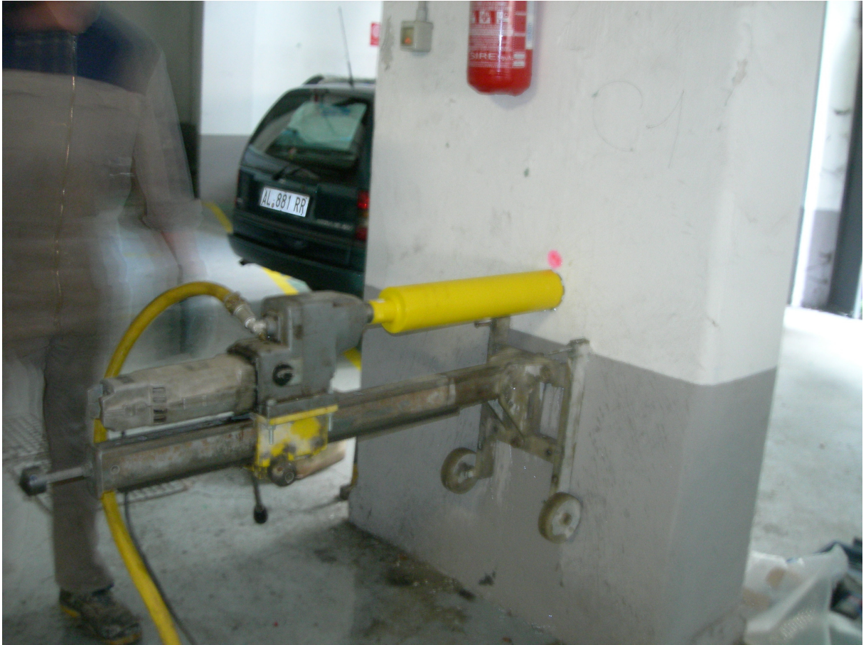
C1 – 1° pilastro parcheggio piano terreno
