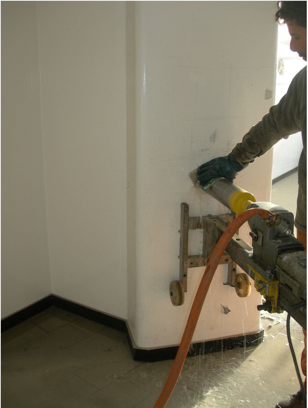
C9 – Pilastro 4° piano
