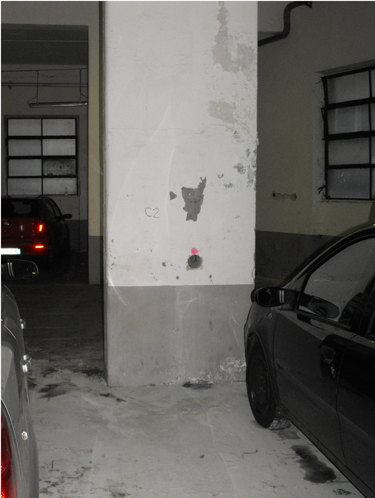
C2 – 2° pilastro parcheggio piano terreno
