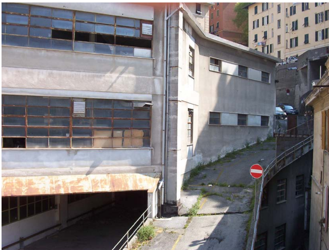
Foto N. 7: rampa superiore per accesso da Via Ponza
