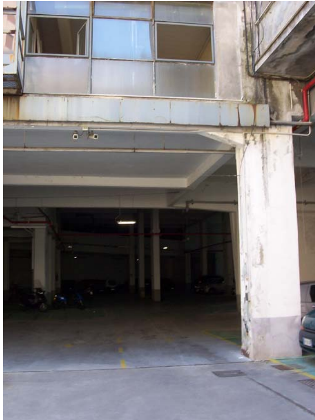
Foto N. 2: accesso piano terra
