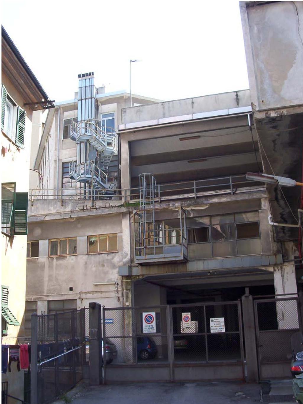
Foto N. 1 - foto dell'edificio da recuperare a parcheggi precedentemente adibito a rimessa bus
